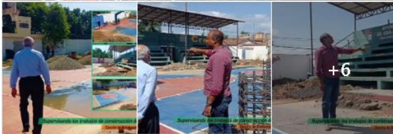
Supervisando los trabajos de construcción del techado Cancha de Baloncesto Club CRERS
